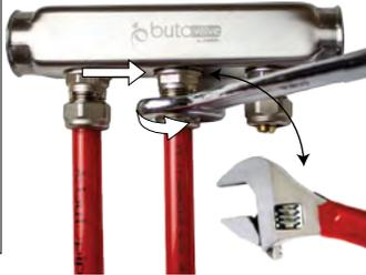
Kollektör ve boru montajı tamamlandıktan sonra sistem, hava veya su ile basınç testine tabi tutulmalıdır. Kollektör, sistem çalışması sırasında periyodik olarak kontrol edilmelidir. (Once installation of manifold and pipe is complete, the system should be pressure tested with air or water. The manifold should be inspected periodically during system operation.)
